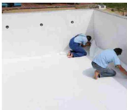
Filc na spojevima ne presavijamo
