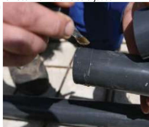
Lijepljenje cijevi
