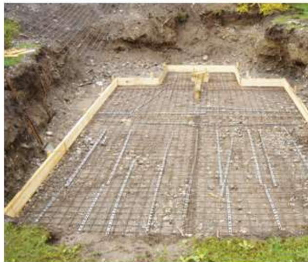
Opaženje in armiranje ploče
