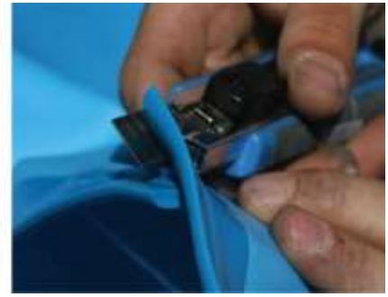
Rezanje viška ruba objesnog profila
