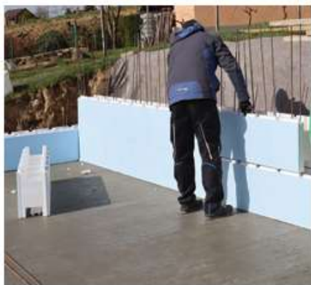
Postavljanje zidova bazena
