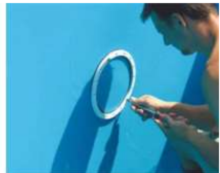
Pričvršćivanje prirubnice reflektora
