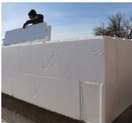
Zalijevanje zidova bazena
