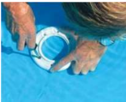
Učvršćivanje prirubnice podnoga odvoda
