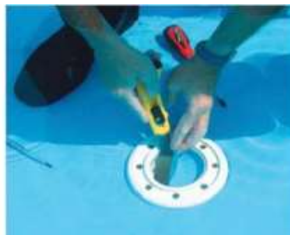
Izrezivanje folije nakon montaže prirubnice
