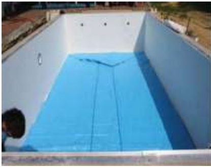
Namještanje folije na dno bazena
