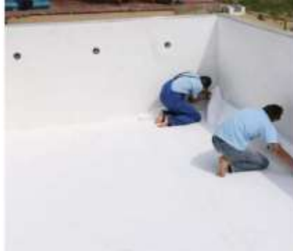
Filc na spojevima ne presavijamo
